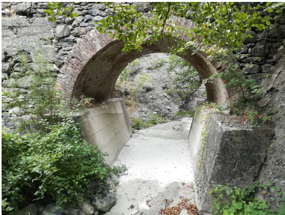
Figura 2 - Ponte sul rio Cascinotto
