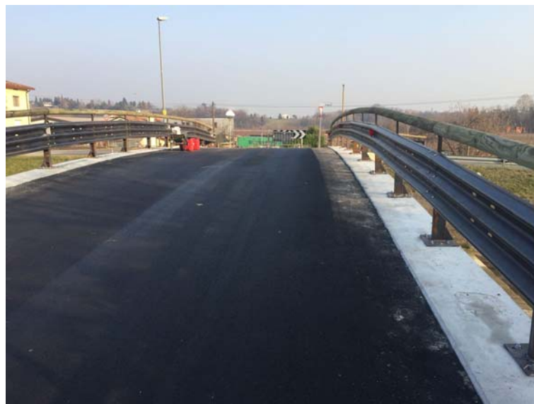
Figura 6 - Barriera di sicurezza in cor-ten
